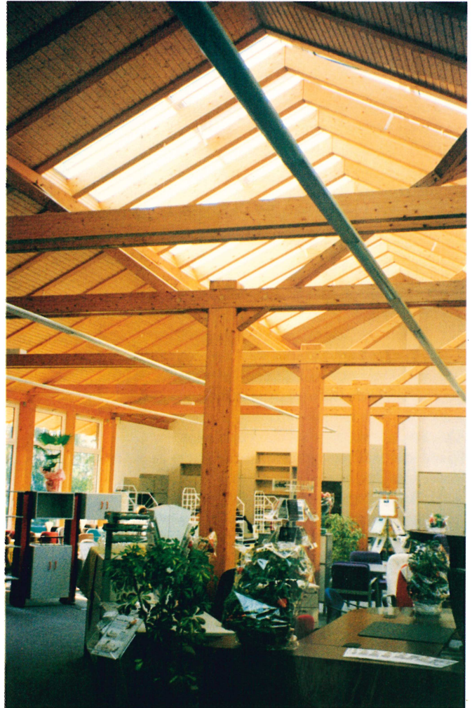
Bild 9: Die »Aufspreizung« von den Mittelstützen zu den Pfetten »öffnet« die Konstruktion zum Lichtband
