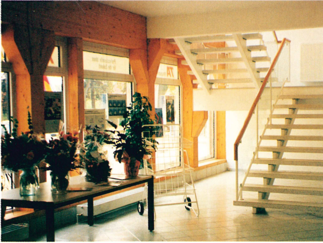
Bild 7: Die »kräftige« Konstruktion mit den Knaggen erinnert an den traditionellen Holzbau
