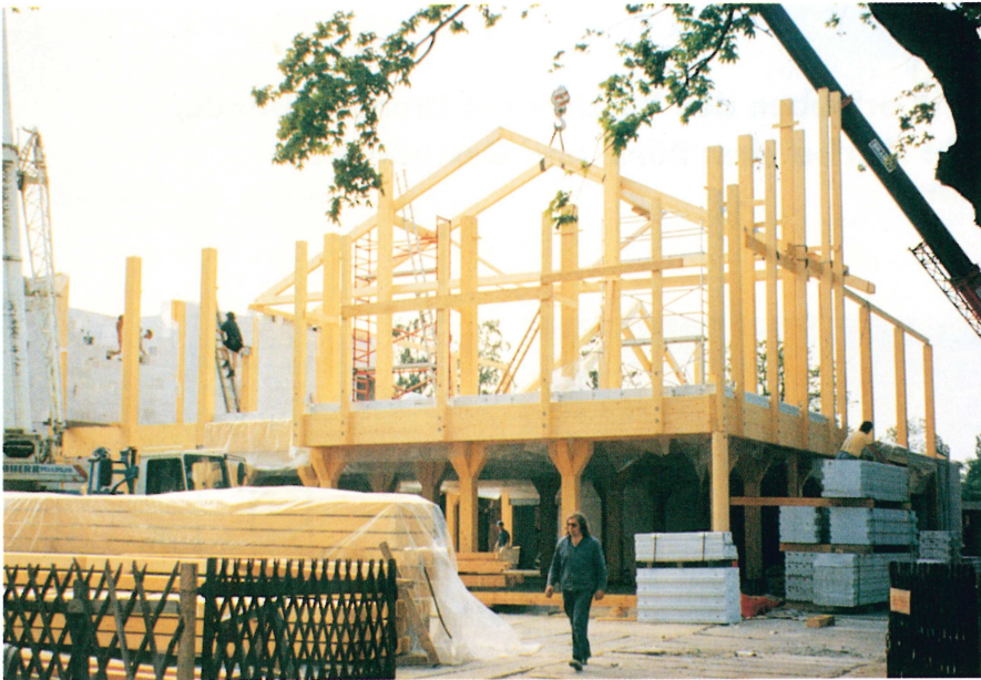
Bild 4: Der Rohbau zeigt: Keine Verbände; rechts liegen die Gasbetondielen für die Decke bereit
