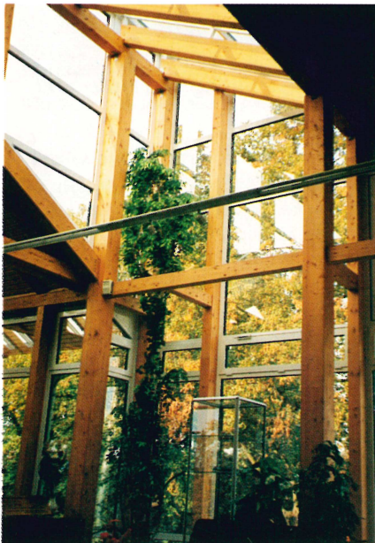
Bild 8: Leicht und luftig: Der Übergang vom Pultdach zum Satteldach
