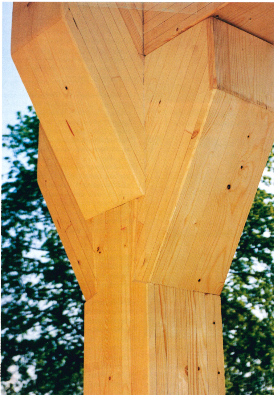
Bild 1: Anschluß Riegel – Stütze, eine saubere Arbeit
