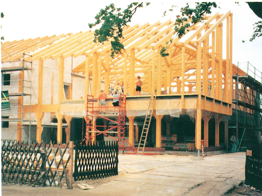
Bild 5: Das Skelett steht, im Hintergrund der »aufgespreizte« Stuhl des Satteldaches
